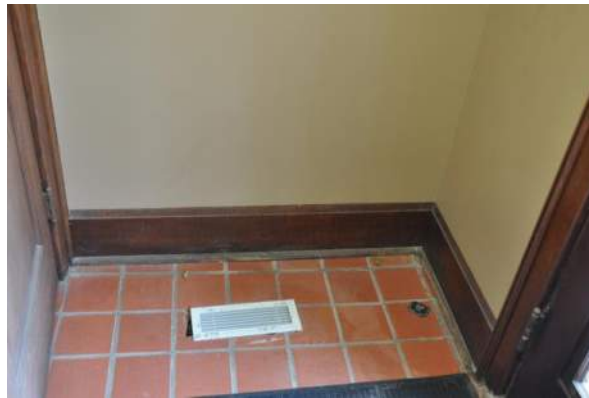
4.5.1.3.A – Entry Vestibule
